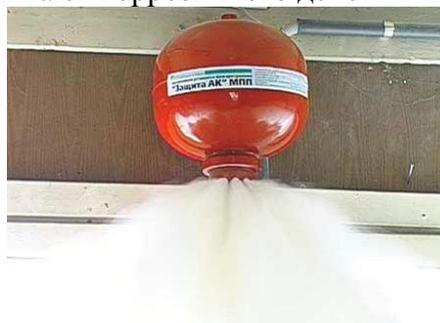
Рис. 6 Модуль порошкового пожаротушения
